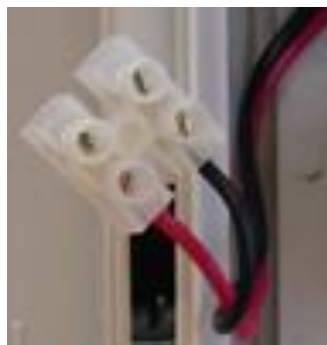
Рисунок 10. Клеммы для подключения замка к блоку питания
